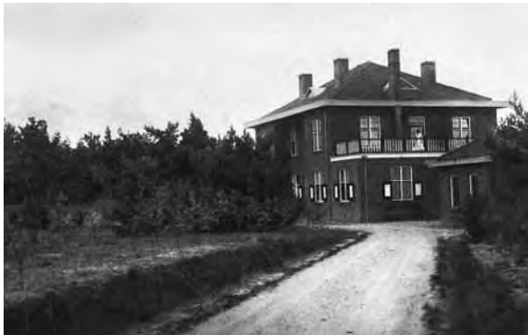
> Woningen voor werknemers van het zendcomplex midden in de eindeloze Veluwe. Hier het directie/ingenieursgebouw.
